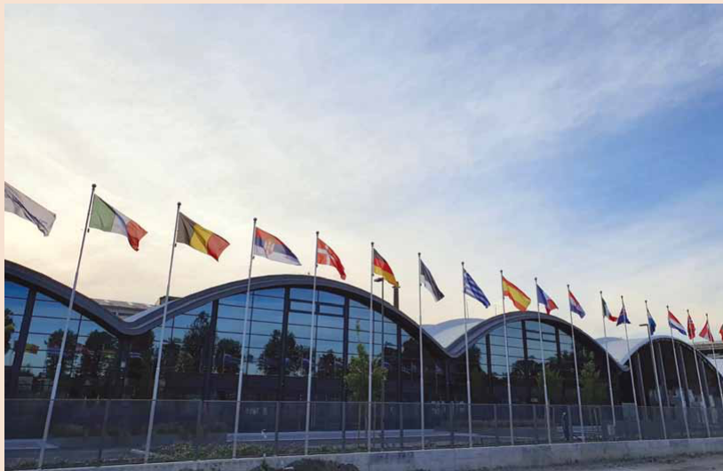
Inaugurazione Data center del Centro Mete Europeo Ecmwf - Riproduzione riservata, copyright Regione Emilia-Romagna
